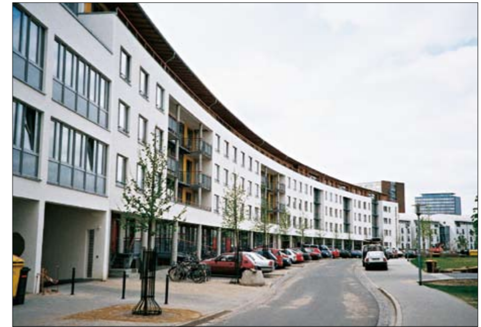
Beheizung einer Neubauwohnanlage. Installierte Gesamtheizleistung: 910 KW
