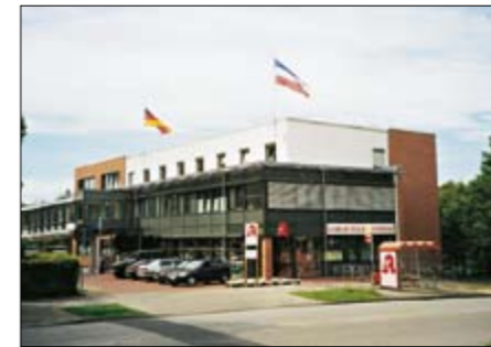
Beheizung eines Neubau-Ärztehauses. Installierte Gesamtheizleistung: 300 KW
