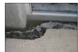
Insgesamt 7000 Liter über 84 Meter umlaufende Randfuge eingeflutet
