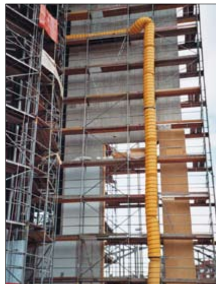
Richtfestbeheizung einer 800 m 2 großen Fläche in der 4. Etage
